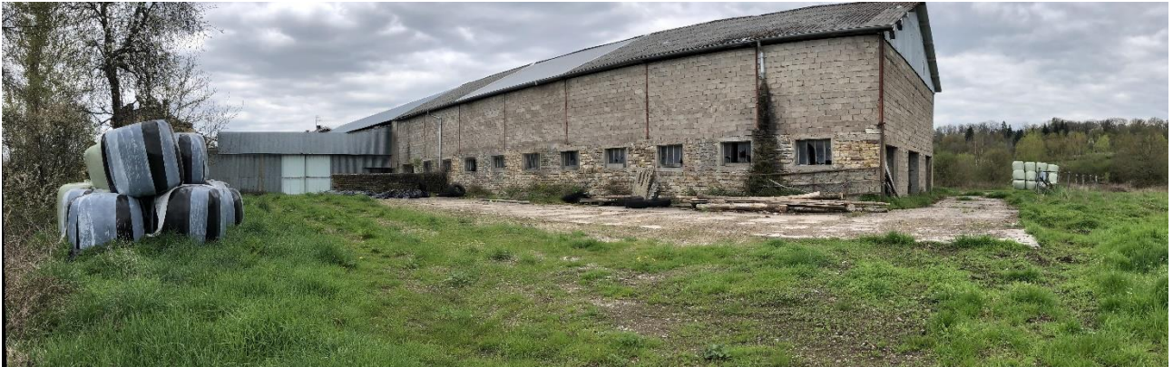
Figure 3 : Zone d'installation de chantier à la centrale
